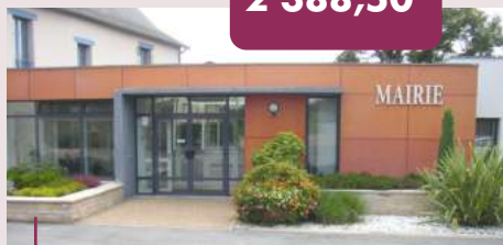
Mairie Rénovation de l'éclairage
