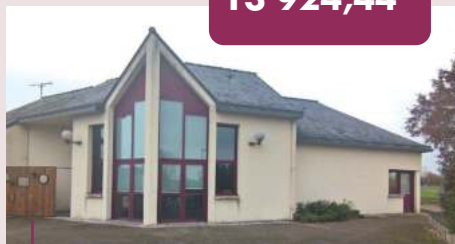
Salle Polyvalente Rénovation de l'éclairage et isolation
