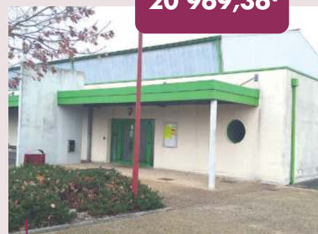
Salle des Sports Rénovation de l'éclairage
